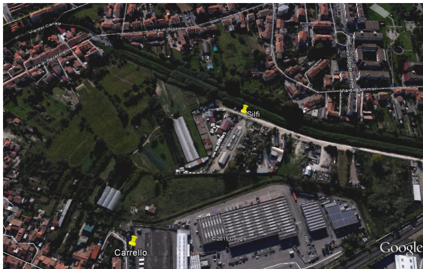
Figura 20: Ubicazione della centralina
