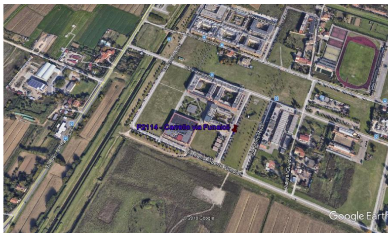
Figura 16: Ubicazione della centralina
