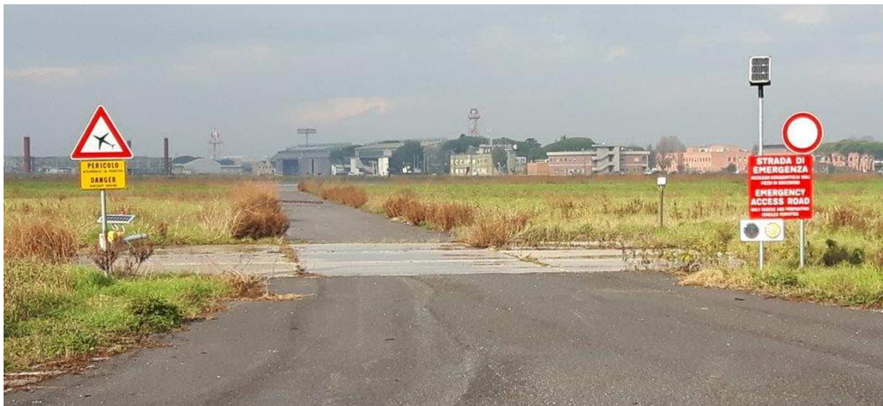
Figura 28 Cartelli di Pericolo -Divieto di transito- pericolo di sorvolo
