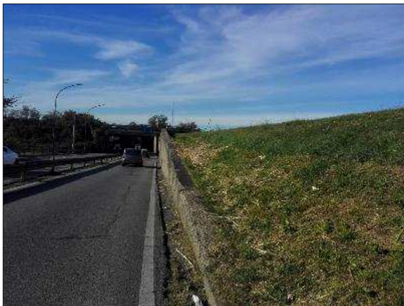
Figura 6-6 Vista del muro di sostegno e del rilevato arginale esistente in adiacenza a via del Cantone
