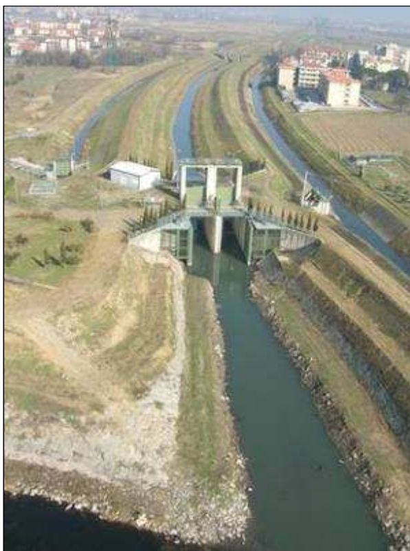
Figura 6-1. Foto delle porte Vinciane vista da valle, lato F. Bisenzio
