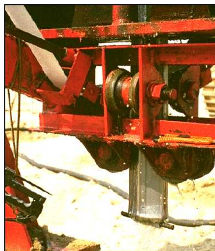
Figura 14 Fasi di posa in opera dei dreni a nastro
