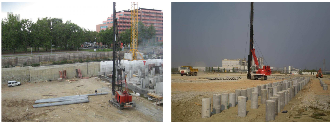
Figura 6 Consolidazione del sottosuolo tramite posa in opera di pali battuti
