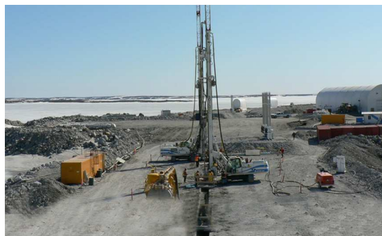
Figura 8 Consolidazione del sottosuolo tramite realizzazione di jet-grouting
