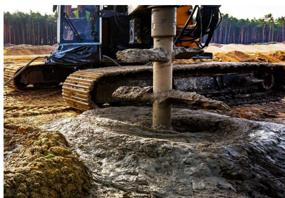
Figura 9 Consolidazione del sottosuolo tramite tecnica deep-mixing
